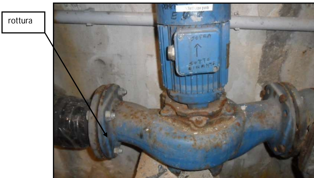
pompe centrale termofrigorifera
